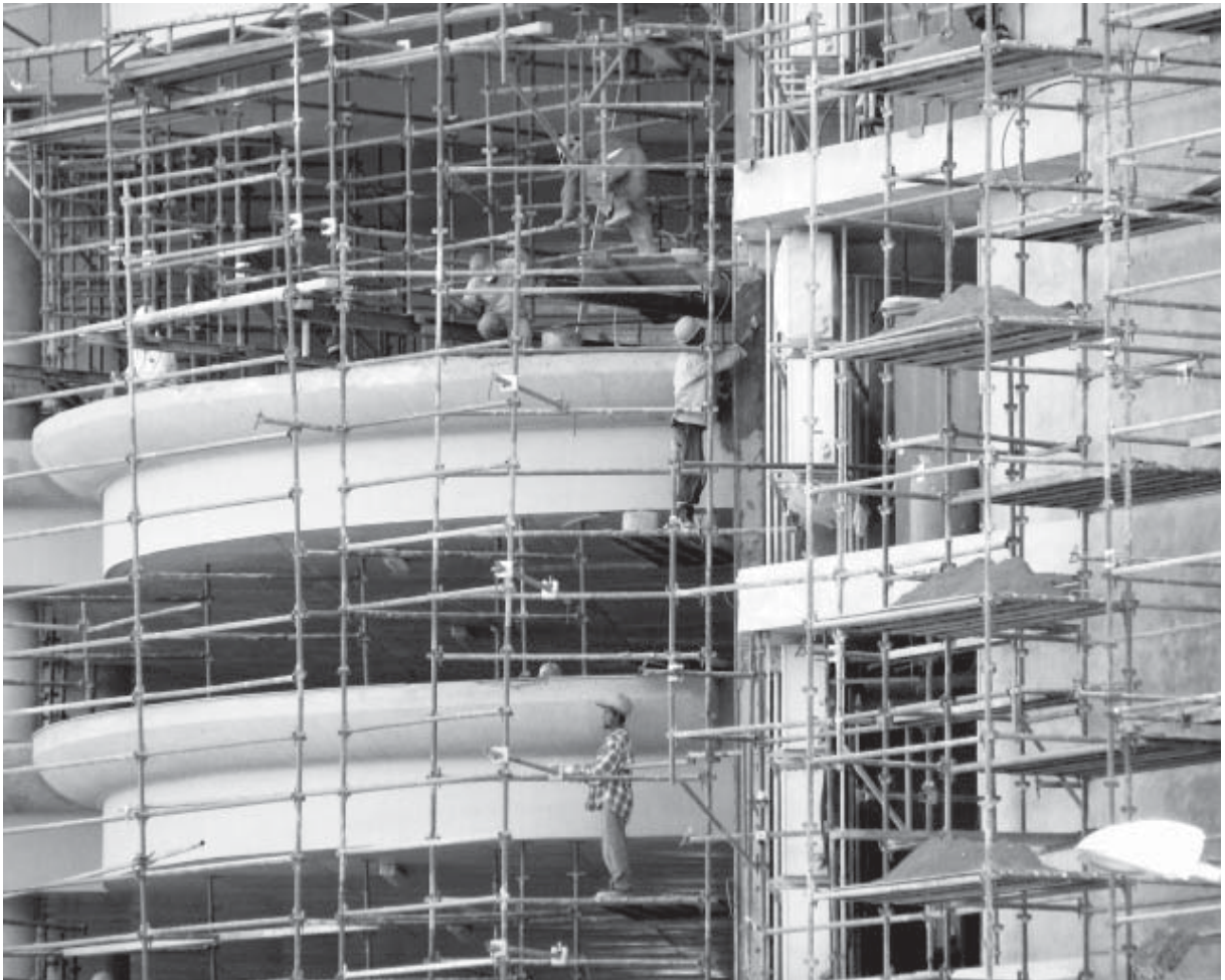
Travayer konstruksyon Moris
